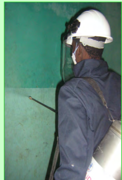
Applicateur qui traite les murs d'une pièce
